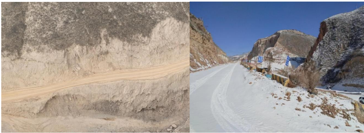
照片3-8 矿区碎石土道路
