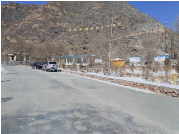
照片 2-2 办公生活区路面硬化
