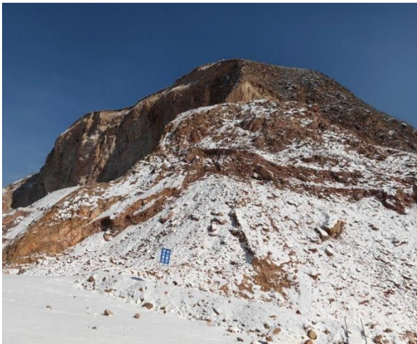
照片 3-4 X4 不稳定斜坡照片
