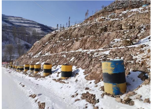
照片 2-3 道路边坡治理现状
