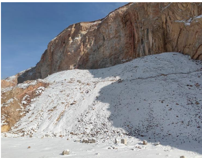
照片 3-3 X3 不稳定斜坡照片
